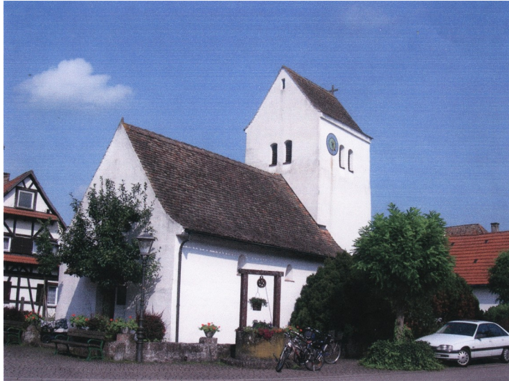
Abb. 19: Heidenkirchl (NIKOLAUS-Kapelle, Keltenkirche ) von Rheinau (Nieder-) Freistett (ehemaliges Fischerdorf von Rheinau), frühromanisches Bauwerk (bisherige Alterseinstufung: um 1000 n. Chr.) mit groben Fundamenten aus Rhein-Wacken, massivem Ziegelmauerwerk von 0,80m Stärke, grau gebrannten Klosterformat-Ziegeln 32 x 16 x 8cm) und einem Buntsandstein-Kreuz auf dem Turm-Ostgiebel (Foto: Prof. Dr. ORTLAM, Bremen).
