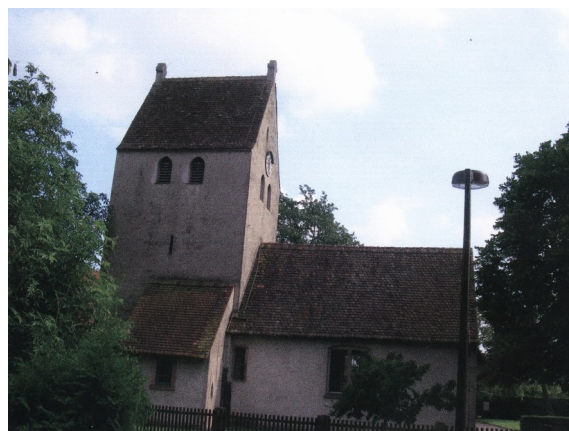
Abb.20: St. NIKOLAUS-Kapelle in Rheinau-Hausgereut mit mächtigem, frühromanischem Turm (Mauerstärke: 0,80m) mit zwei keltisch-gälischen Buntsandstein-Giebelkreuzen und daneben einem unproportioniert kleinen Kirchenschiff (Mauerstärke: 0,50m) von 1288 n. Chr. (Foto: Prof. Dr. ORTLAM, Bremen).
