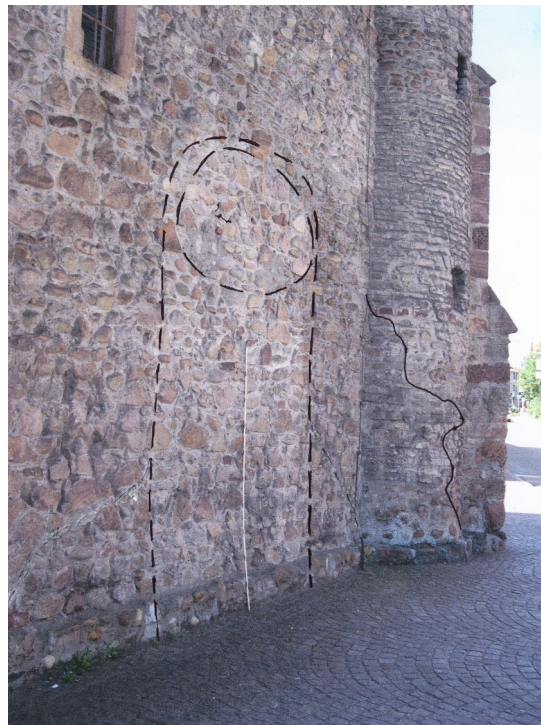
Abb. 11: Intakte Nordwand der NIKOLAUS-Kapelle mit dem Schattenriss des beim letzten Umbau wieder entfernten Krieger-Ehrenmals (1914-18) und rechts die Abrisslinie des Stark-Bebens von 1601 am Turmsockel (Foto: Prof. Dr. ORTLAM, Bremen).
